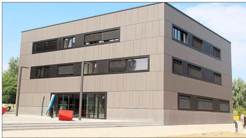
Das Gebäude beherbergt nun die Hochschulleitung und das Zentrum für Angewandte Forschung, Marketing und Öffentlichkeitsarbeit.
